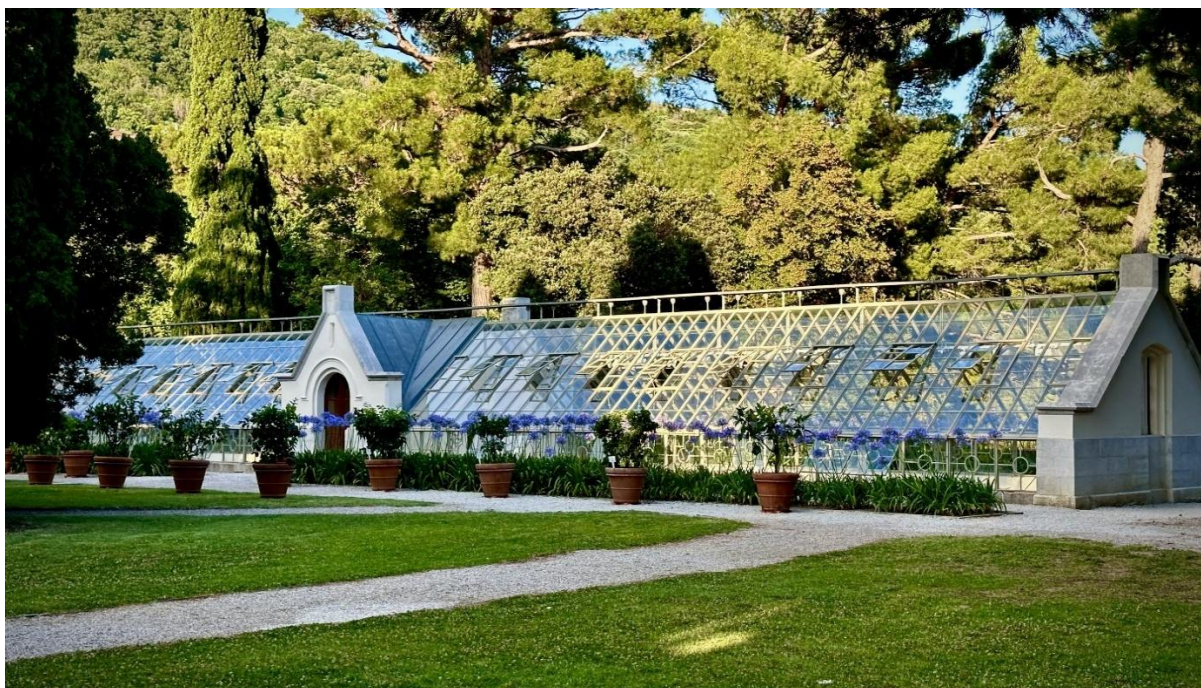
Figura 22: Parco storico del Castello di Miramare - Serre
