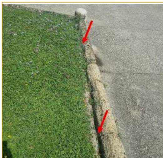
Figura 108: Distanza fra margine del prato e cordolo di tufo variabile per la diversa quantità di terreno
