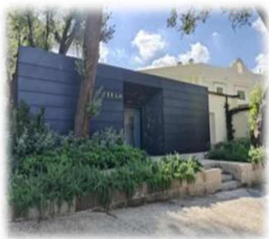
Figura 128: Nuovi servizi igienici
