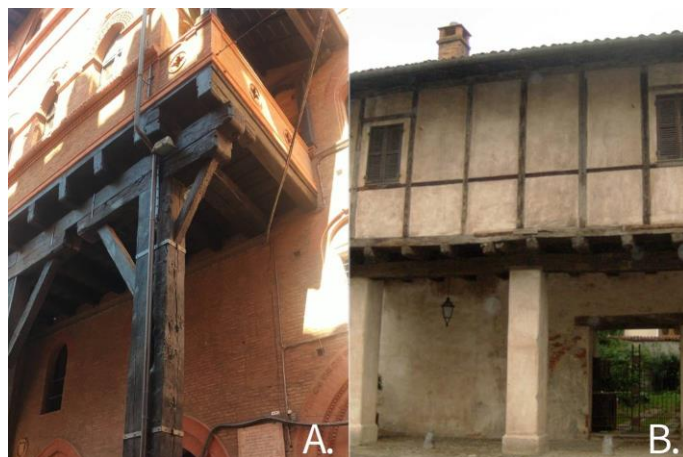
Fig. 38. A. Dettaglio di un edificio porticato, Bologna (BO); B. Dettaglio di una “casa a graticcio”, Biella (BI).
