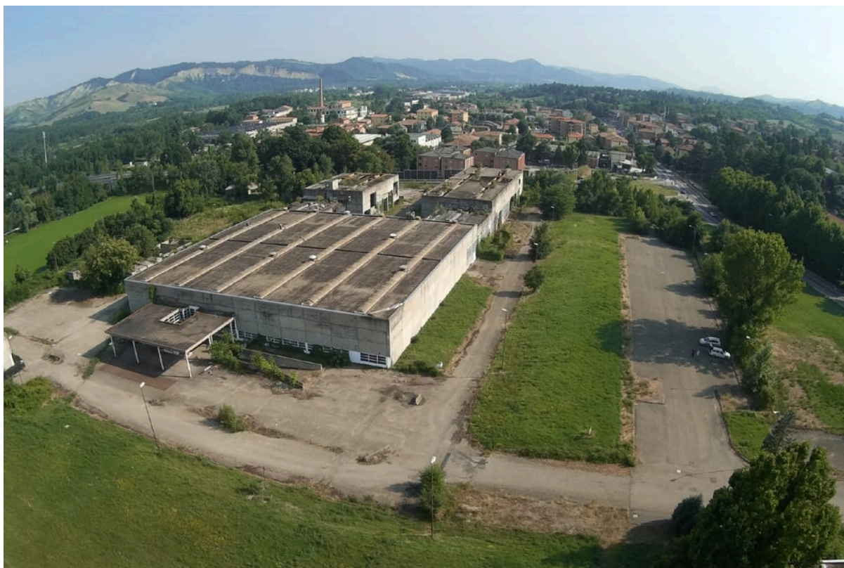
Vista del complesso produttivo dell'ex Alfa-Wassermann prima delle demolizioni.
