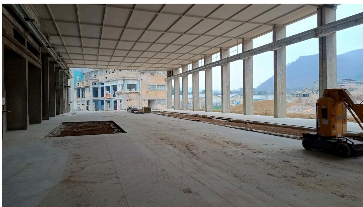
Vista di uno degli ambienti della Ex Cartiera destinato a diventare “podio coperto” dal progetto di rigenerazione. In alto prima dell’inizio dei lavori nel 2023 e in basso durante i cantieri nel 2025. Foto dell'autore
