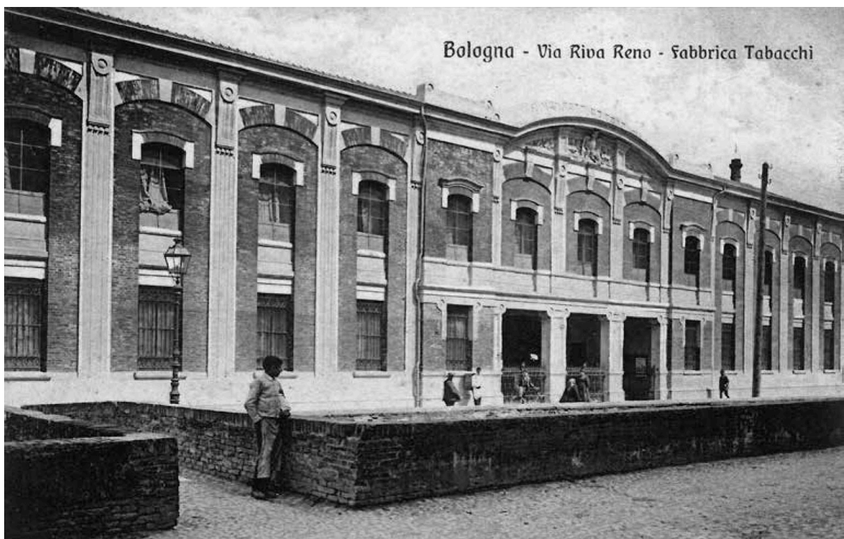
Manifattura Tabacchi in via Riva Reno, tra le aree dismesse indicate dal PIC da destinare a servizi. Fonte: Antonucci M., Trentin A. (a cura di), La Manifattura Tabacchi a Bologna... , cit., p. 38
