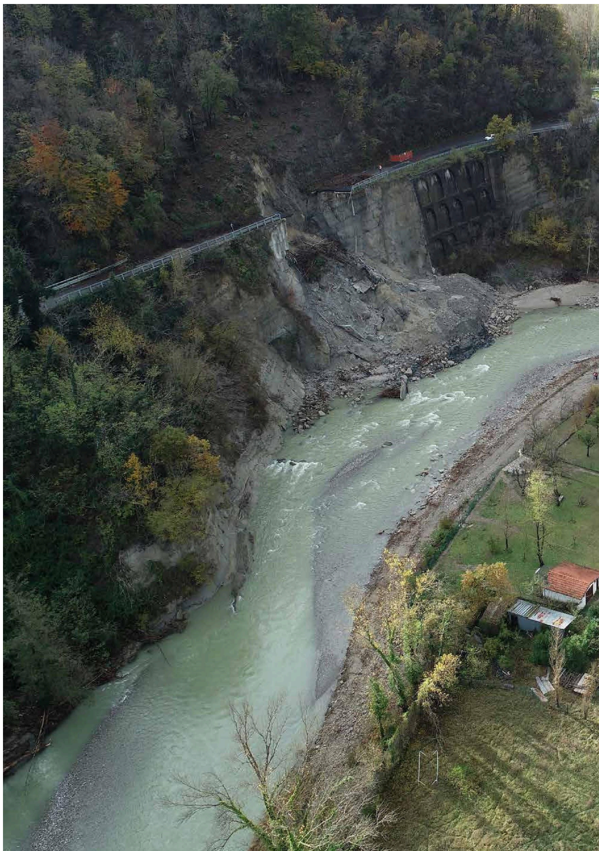
Frana di Gardelletta lungo il fiume Setta, esempio della fragilità idrogeologica dell'area metropolitana bolognese. Fonte: Città metropolitana di Bologna, Piano Territoriale Metropolitano , cit.
