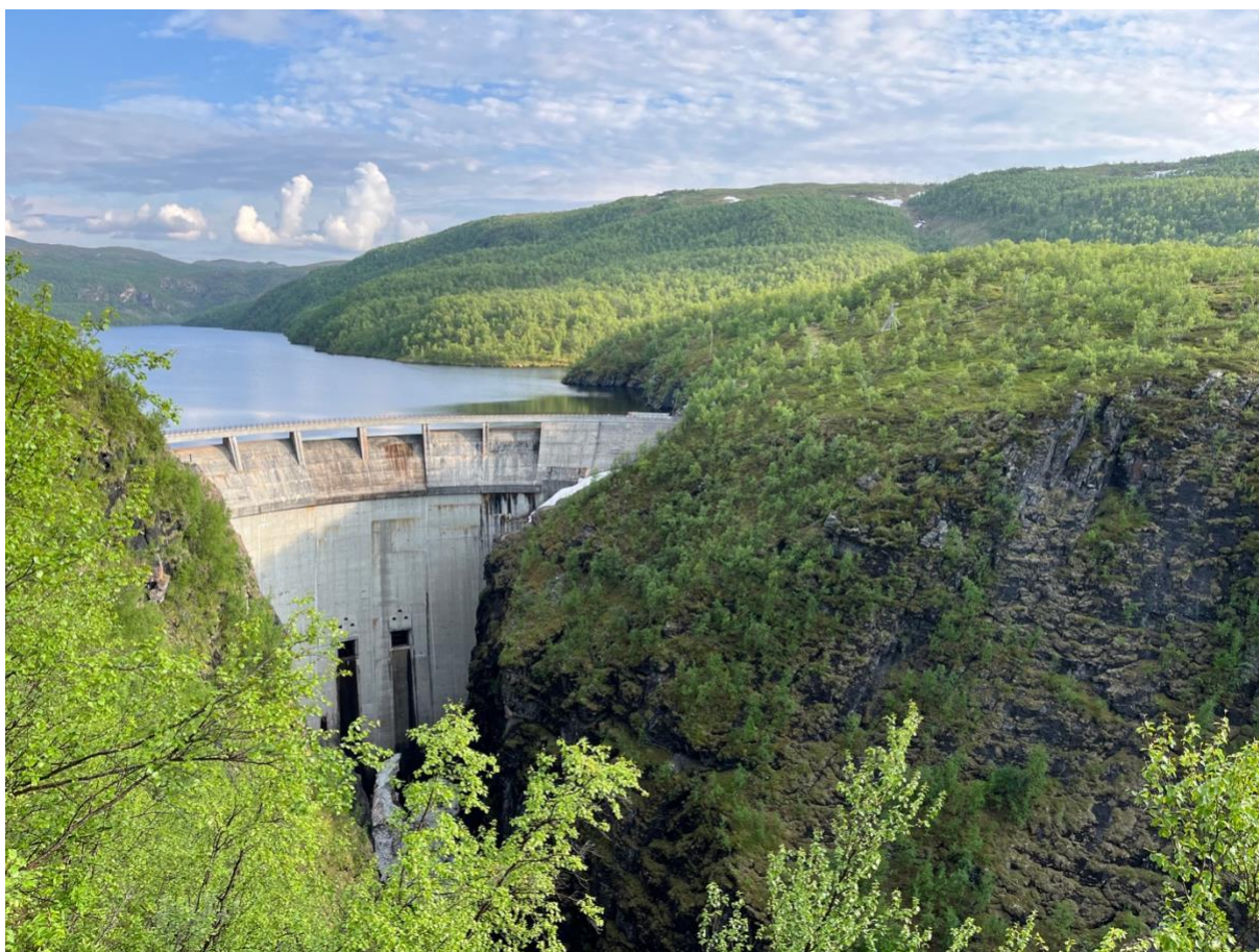
Figure 29 Alta hydropower plant, at Čávžu, Áltá.
