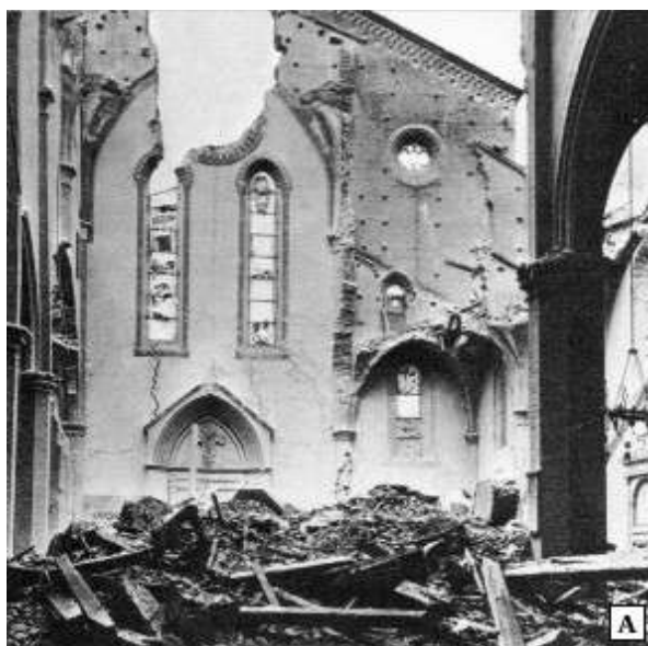
A : Basilique S. Francesco, vue interne de la façade (Barbacci, 1953)
