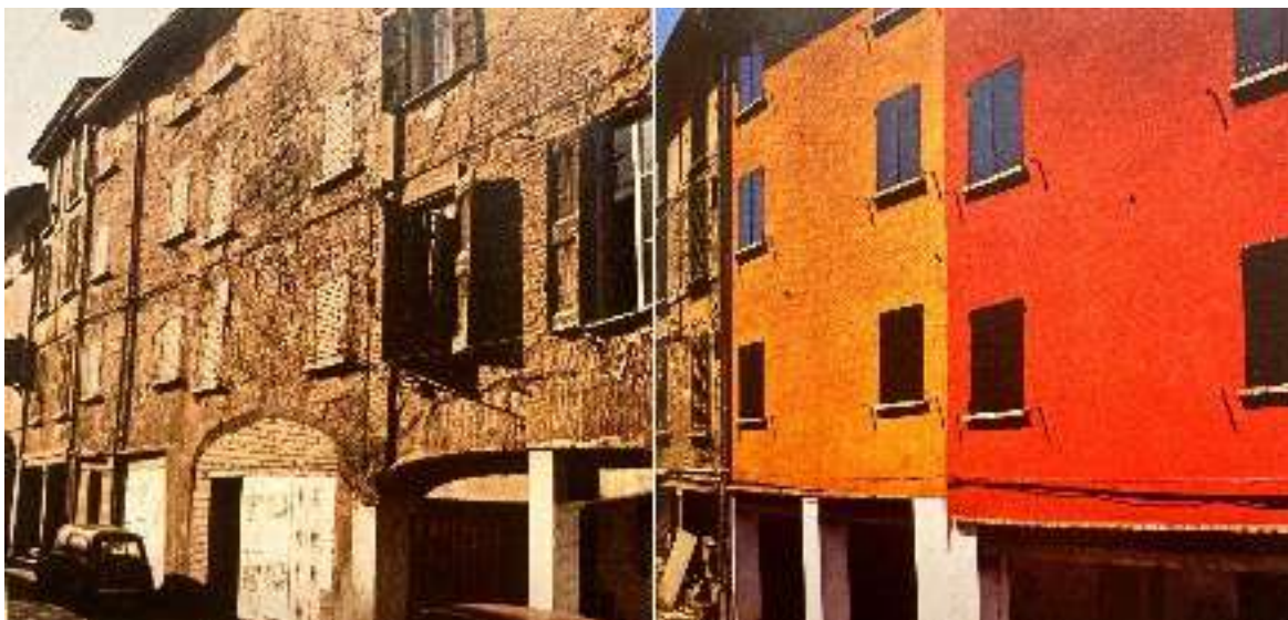
Figure n° 16 : Photographies des édifices de la rue Santa Caterina avant et après leur réhabilitation
