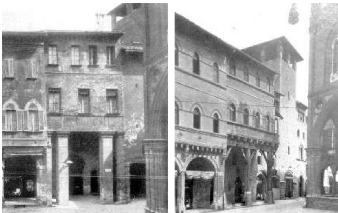
Figure n° 17 : Photographies de l'état de la Casa Pasi (au centre) avant et après sa restauration
