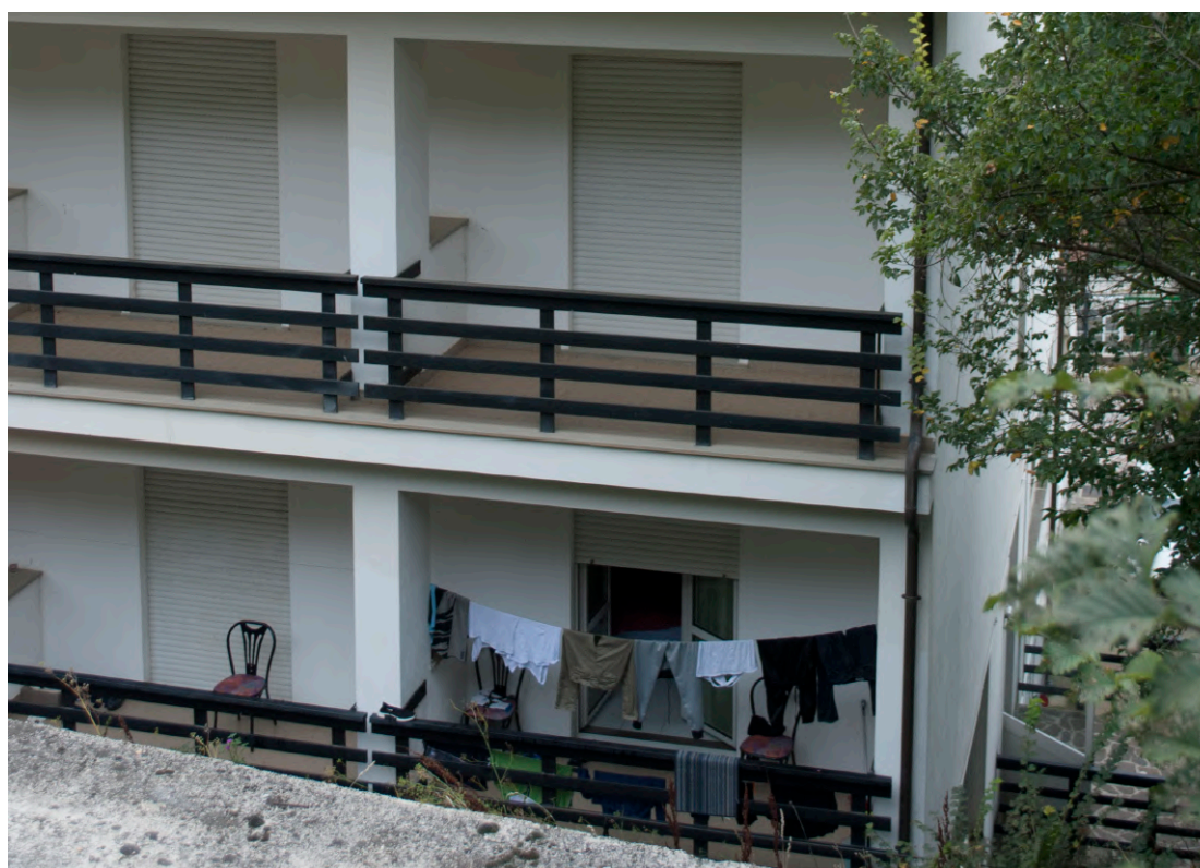
Fig. 4 L'esterno dell'ex Hotel Gioia. Centro per minori non accompagnati. Fonte: Google Maps. Vagando per San Severino Lucano mediante la modalità Street View di Google Maps mi imbatto in un'immagine che non avevo mai catturato con la macchina fotografica ma che tuttavia è particolarmente rappresentativa della vita quotidiana presso il centro.
