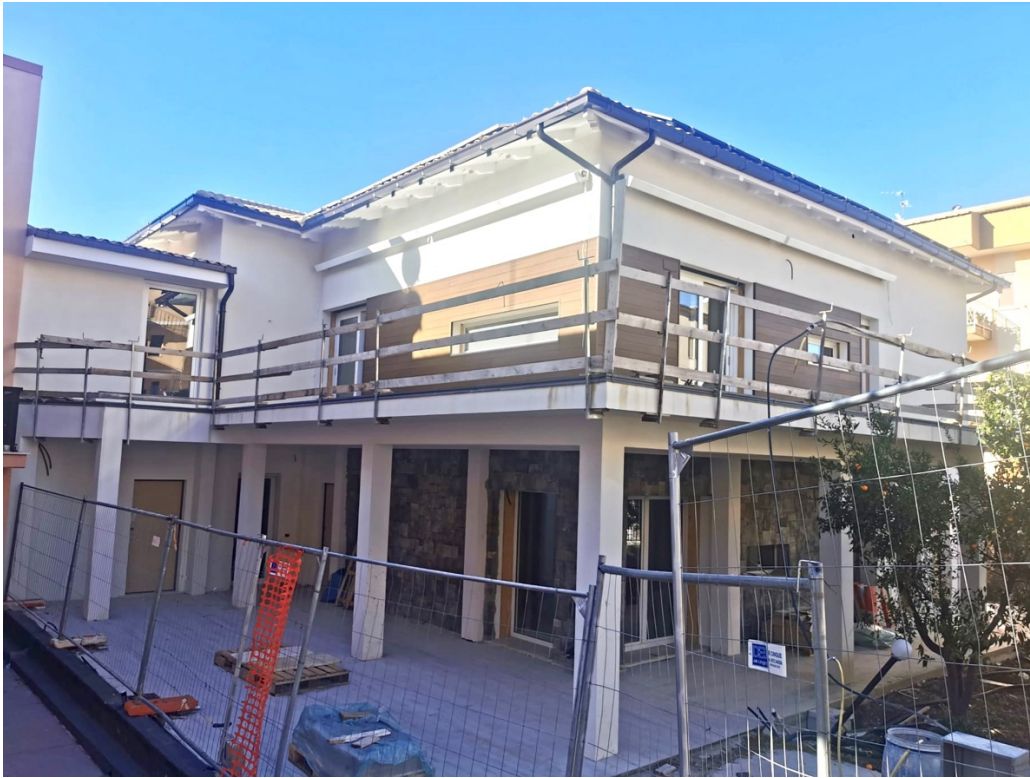
Figura 207- Villa Montenero di Bisaccia, stato attuale, durante i lavori di riqualificazione, SE
