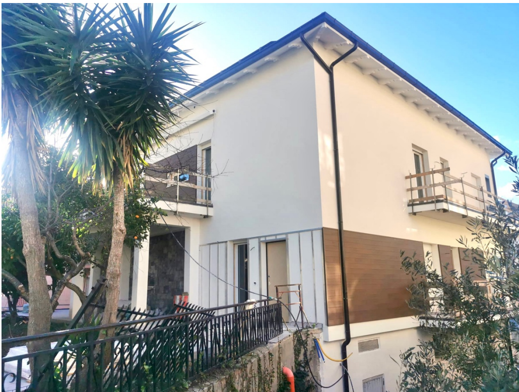
Figura 208- Villa Montenero di Bisaccia, stato attuale, durante i lavori di riqualificazione, NE
