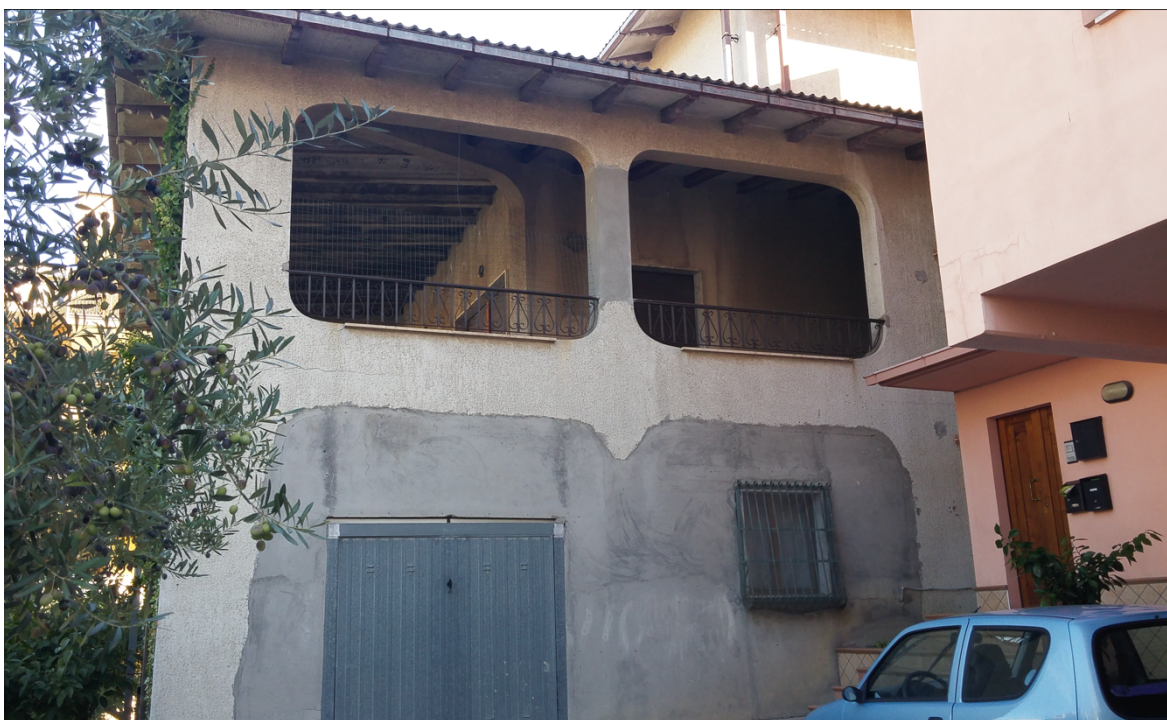
Figura 204- Villa Montenero di Bisaccia, Facciata Sud, prima della riqualificazione
