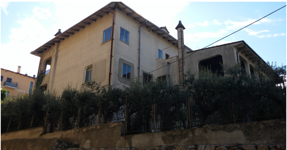
Figura 203- Villa Montenero di Bisaccia, Facciata Nord, prima della riqualificazione
