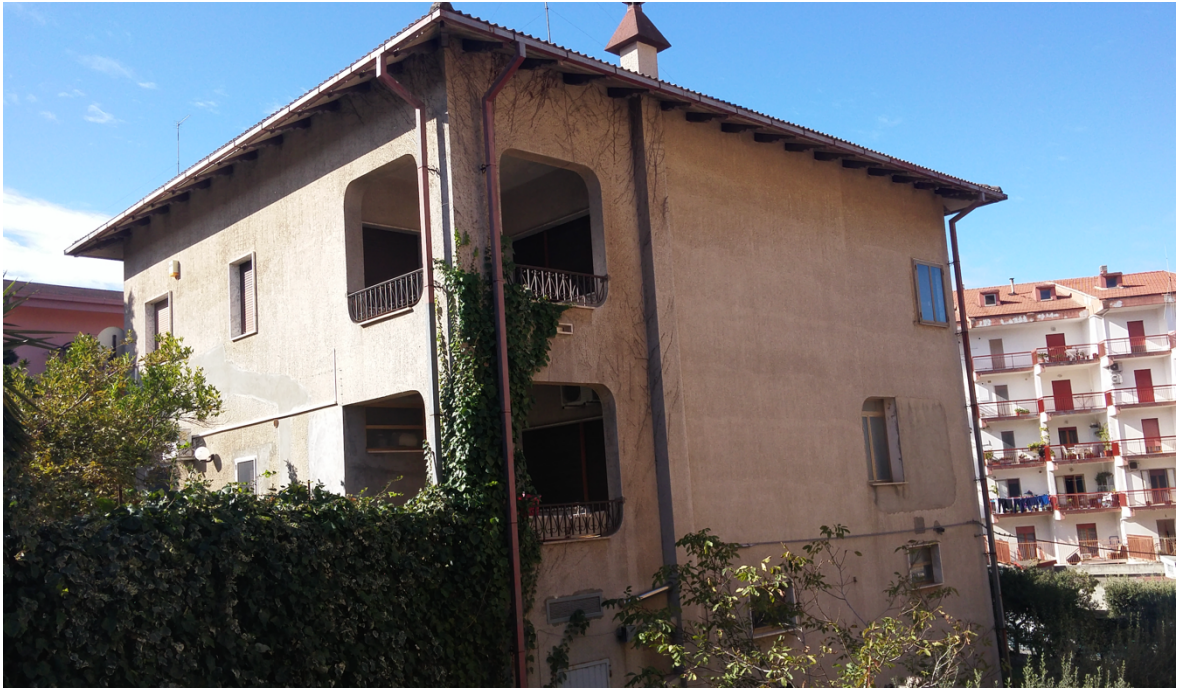
Figura 202- Villa Montenero di Bisaccia, Facciata Nord, prima della riqualificazione
