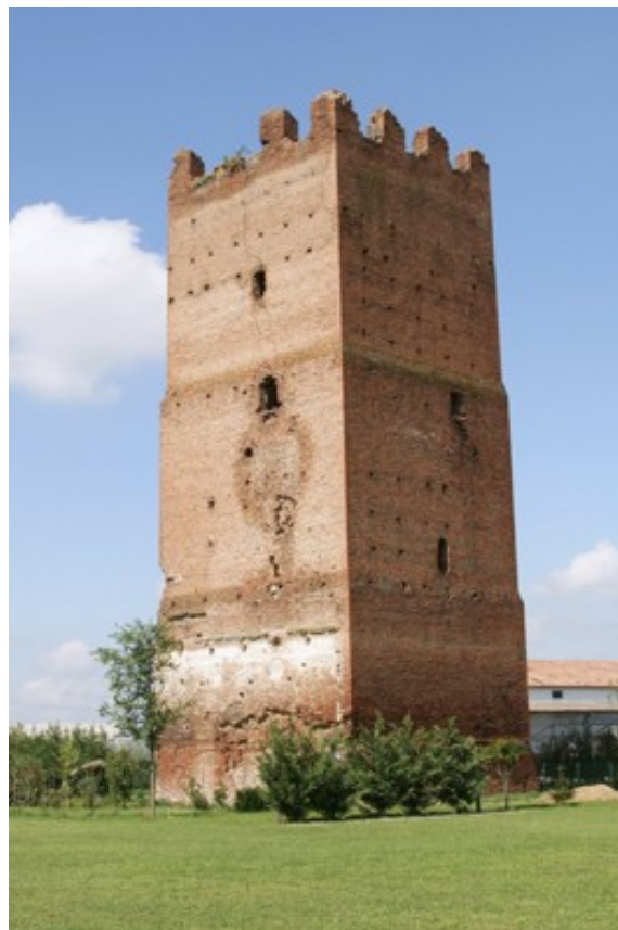
Fig. 17 – La torre dell'Uccellino così come è visibile ancora oggi. Ad essa erano addossati altri edifici, di cui si notano le tracce degli ammorsamenti sui prospetti esterni della torre.
