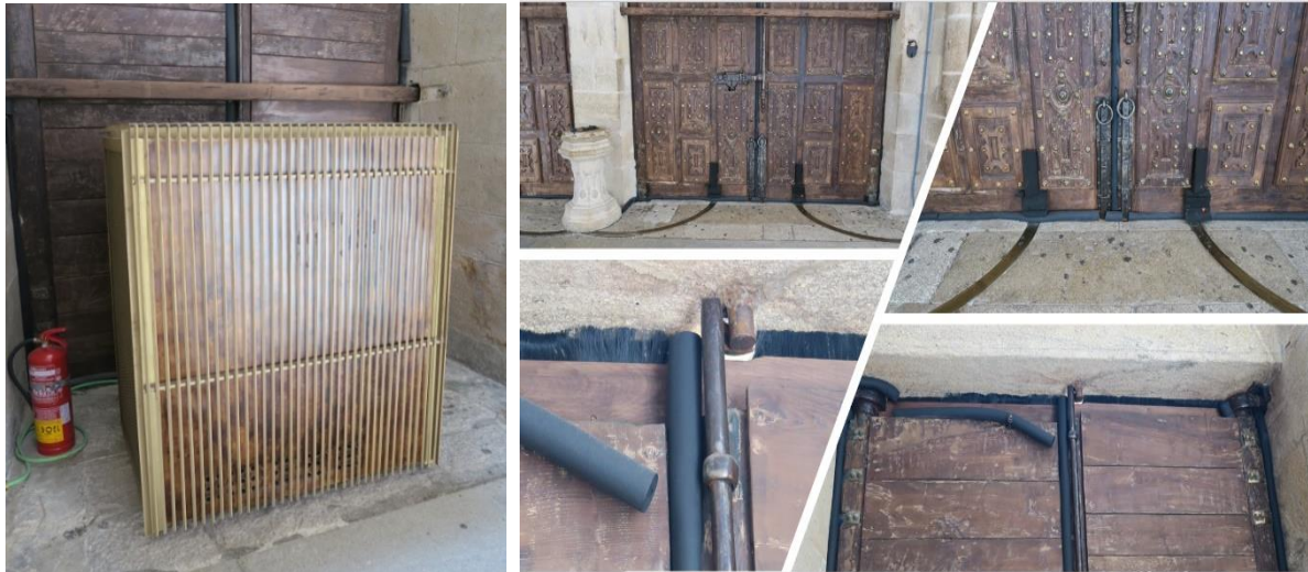
Figura 85_Portico della Gloria: a sinistra una delle due UTA presenti, a destra il Portale dell'Obradoiro 258
