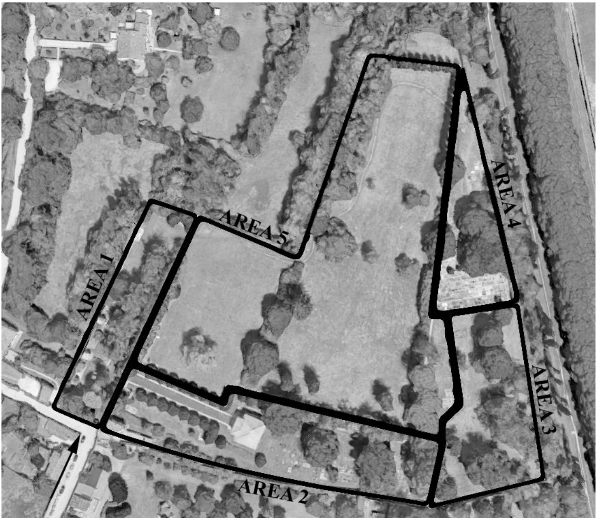
Fig. 1 - Foto aerea del cimitero ebraico di Via delle Vigne a Ferrara, elaborata dall'autore per evidenziare le cinque aree in cui può essere suddiviso.
