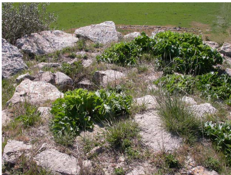
Figura 4.55 – Scorcio della parte sommitale della torre centrale, ‘sigillata’ con un massetto in malta cementizia negli anni '70.
