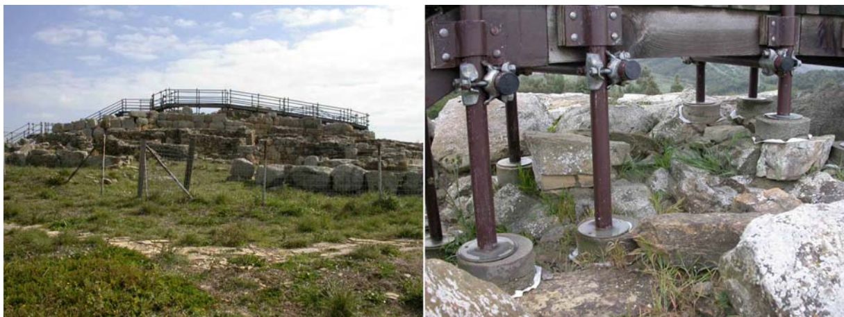
Figura 4.47 – La passerella in opera dal 1995 per il controllo dell’usura antropica ed i relativi appoggi in calcestruzzo, direttamente sul monumento.
