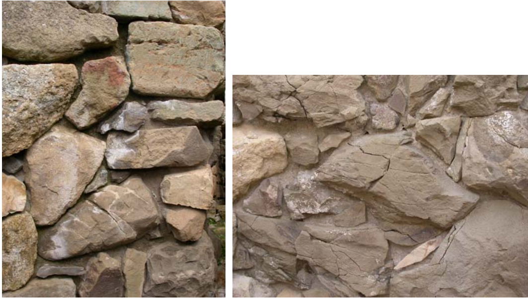
Figura 4.18 - Presenza di sali in torre sud (marzo 2005).
