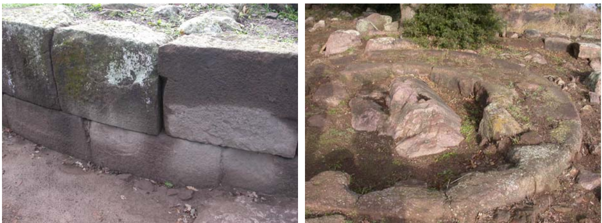
Figura 4.36 - A sinistra muratura esterna del lato nord di A; a destra vano E.
