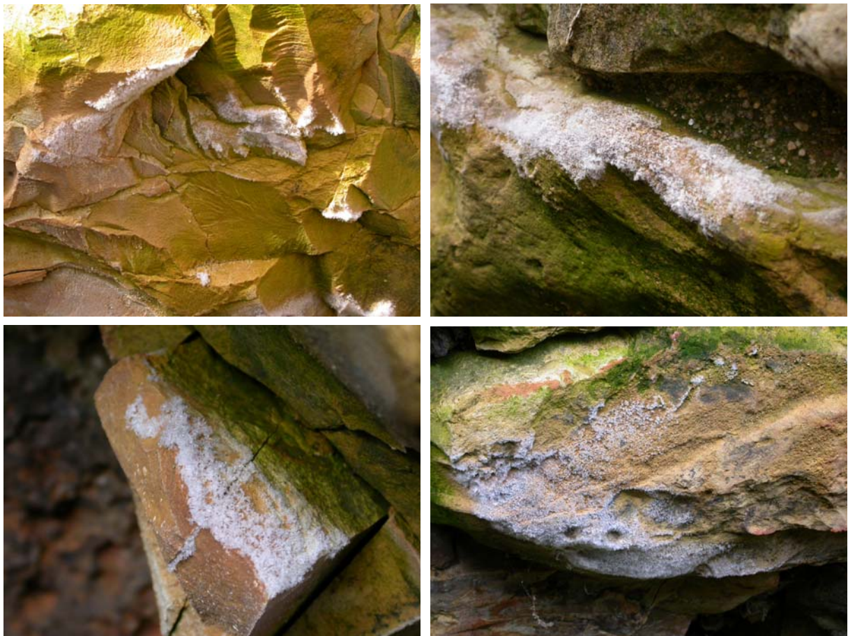
Figura 4.19 - Presenza di sali nel corridoio di accesso al mastio (marzo-aprile 2005).
