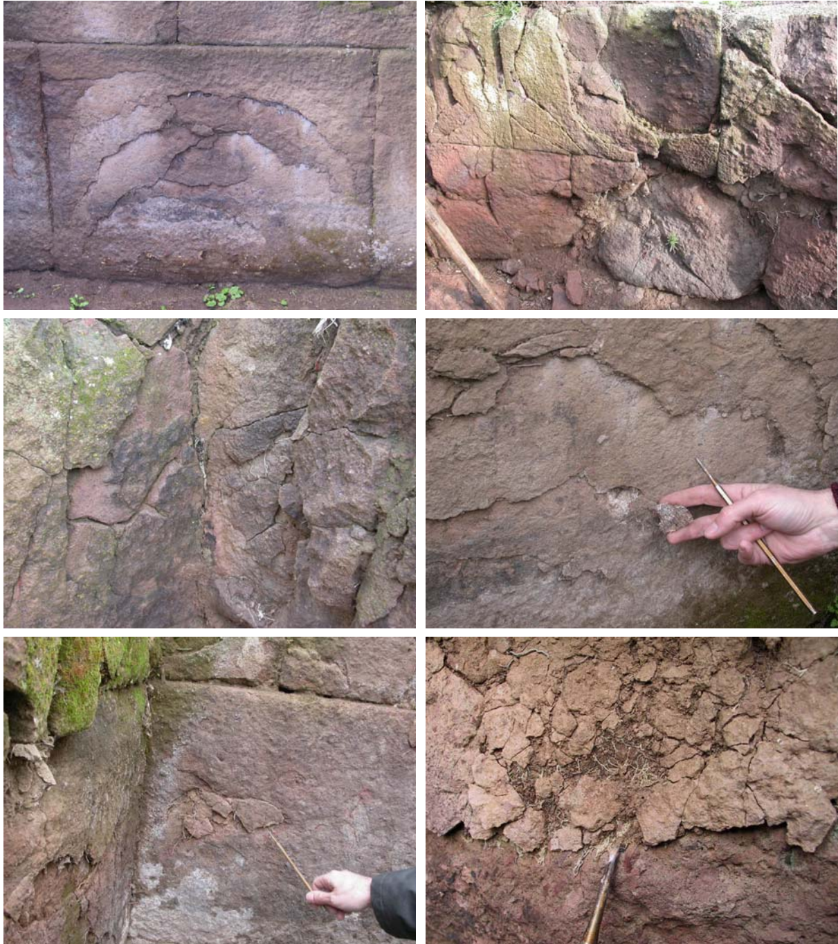
Figura 4.42 - Manifestazioni di scagliatura e polverizzazione sempre associate a radici, paramento interno del vano A ('Tempio').
