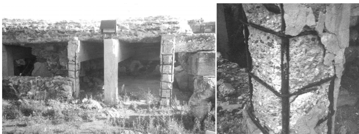
Figura 4.9 - Sito archeologico Romano di Nora-Pula: esempi di corrosione delle armature su opere di consolidamento.
