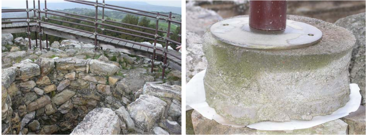
Figura 4.21 - Passerella e particolare di uno dei basamenti in calcestruzzo (marzo 2005).
