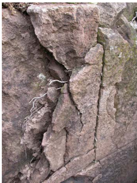
Figura 4.41 - Apparato radicale strettamente associato al degrado del materiale litico.
