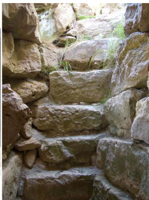
Figura 4.51 - Apertura della scala intramuraria: a sinistra vista dal tetto, a destra vista dall'interno (maggio 2006).
