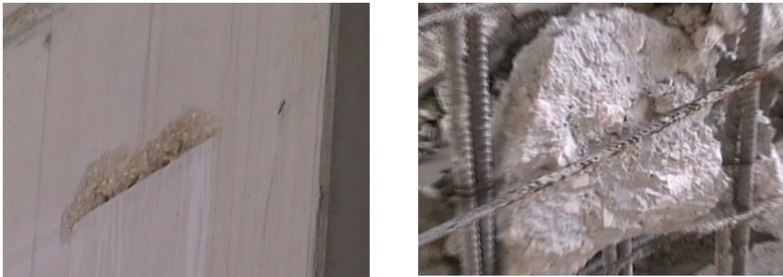
Figura 5.11: Distacco di calcestruzzo e ossidazione dell'armatura
