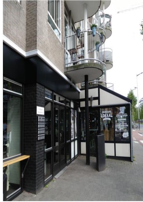
Figura 52. Bar ristorante "Lokaal".
