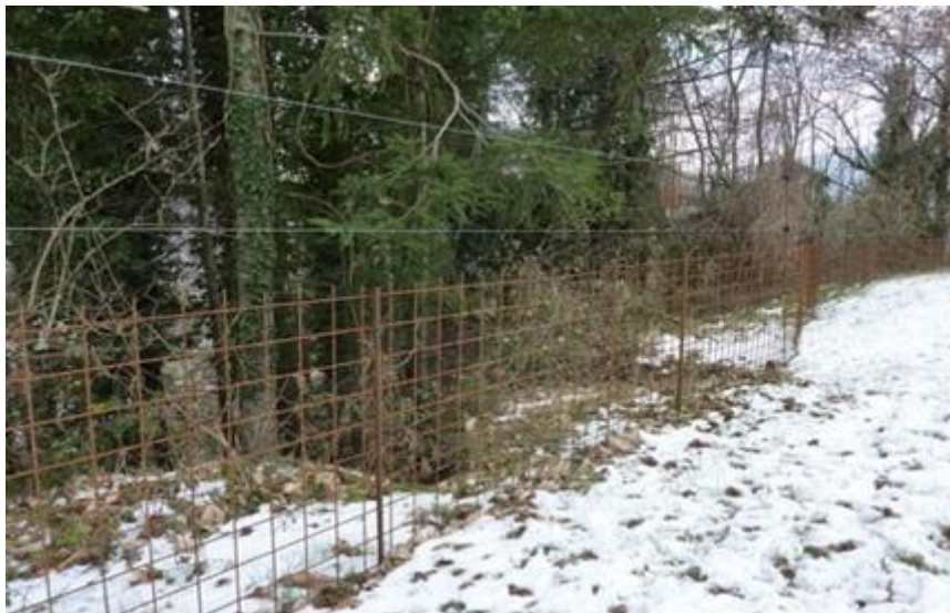
Fig.3.12c Esempio di recinzione mista realizzata con reti da edilizia (altezza 1 metro) e tondino di ferro da 16mm, con due cavi elettrici sovrastanti (Berzi, 2014)
