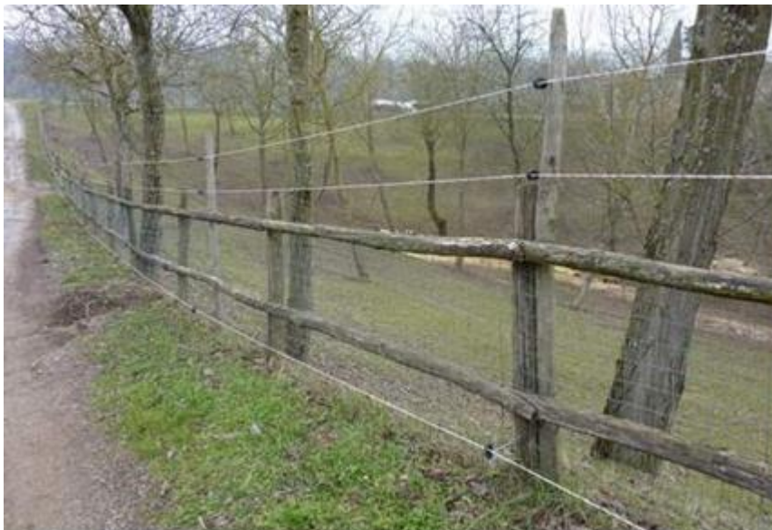
Fig.3.12a Esempio di recinzione mista realizzata montando 3 cavi elettrici con isolatori "a braccetto" di 20cm su pali di legno esistenti (Berzi, 2014)
