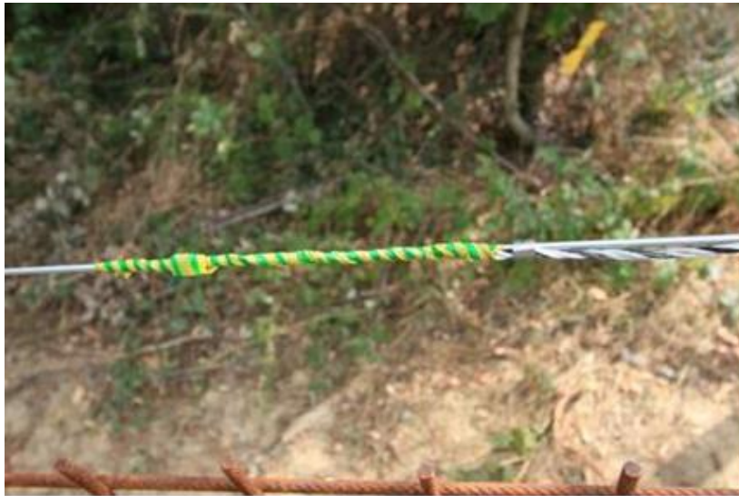
Fig.3.19 Esempio di corretta giunzione tra cavi (Az. Agricola i Pianacci, Scarperia)(foto Berzi, 2014)
