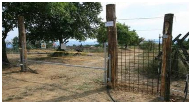
Fig.3.17 Un cancello elettrificato con a fianco un piccolo ed efficace cancello artigianale, realizzato con rete elettrosaldata da edilizia (Az. Agricola i Pianacci, Scarperia) (Berzi, 2014)
