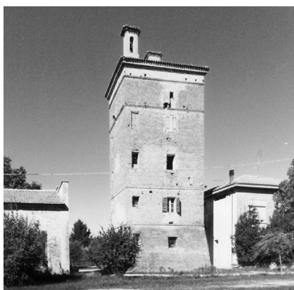
Torre di corte Malcantone, Medolla, prima del sisma
