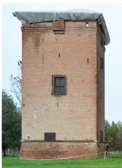
Torre di Palazzo Castelvetro, San Prospero sulla Secchia (Fda 2015)
