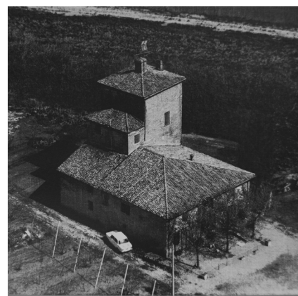
Casa Colombaia, Camposanto, prima del sisma
