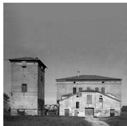
Palazzo Castelvetro, San Prospero sulla Secchia, prima del sisma
