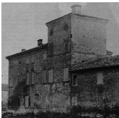
Casa Il Cantone, San Felice sul Panaro, prima del sisma
