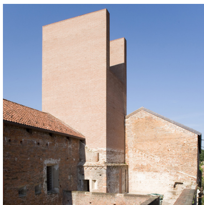
Inserimento della nuova torre, Castello Sforzesco-visconteo , Novara, 2010 ©ZermaniAssociati, particolare
