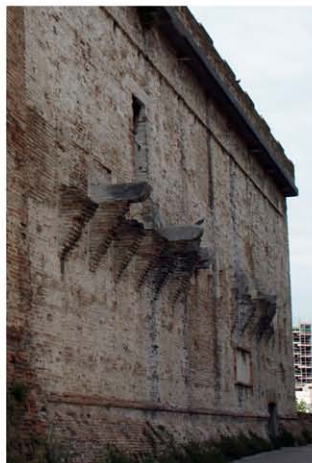
Fig. 27 A sinistra: Castel Sismondo, Ala di Isotta vista da sud-est, 2016
