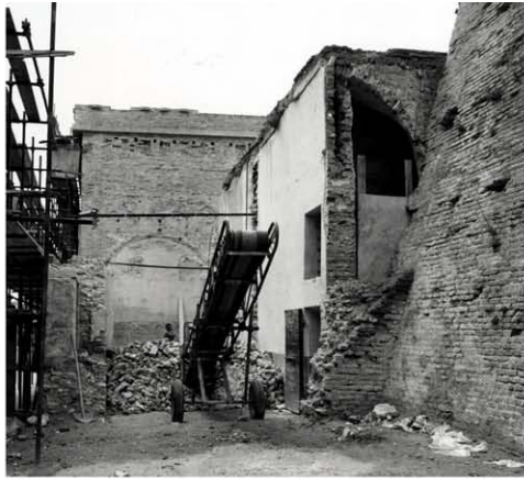
Fig. 23 Castel Sismondo, demolizione del magazzino del sale, 1974
