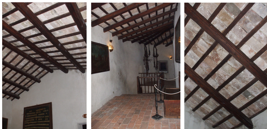
Fig. 28-29-30 Da sinistra: Castello di Montebello, nuove coperture degli ambienti del fronte occidentale, 2011
