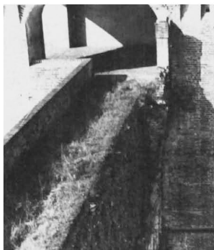
Fig. 13-14 A sinistra: Rocca di Soncino, spalto orientale visto dalla torre sud-est, 1967. A destra: Rocca di Soncino, spalto orientale visto dalla torre sud-est, 1975
