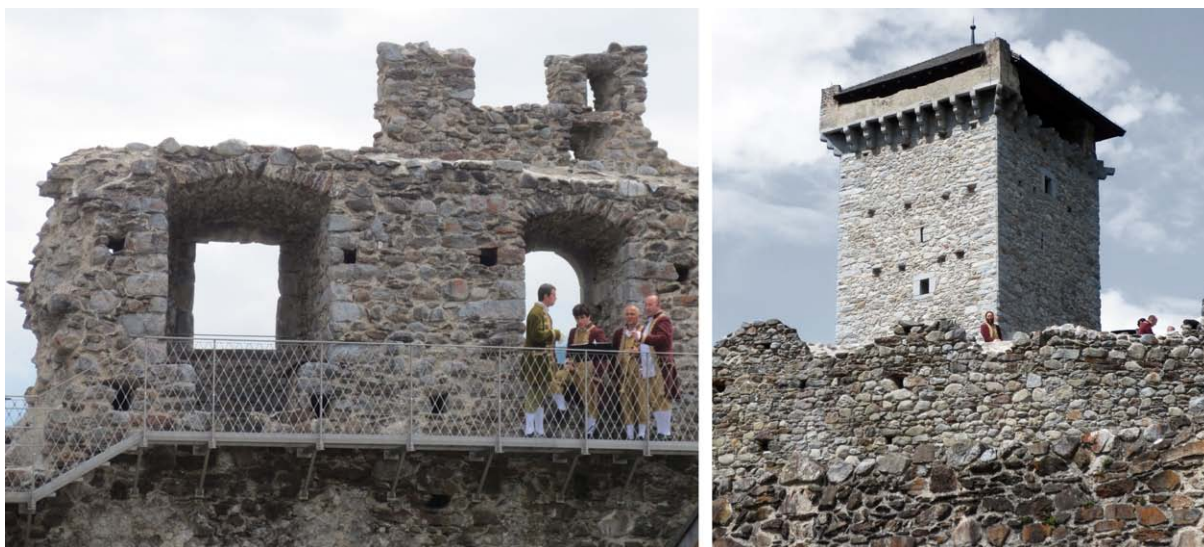
Fig. 37-38 Castello di Ossana, percorso aereo parallelo alla cortina orientale della prima cinta e torre principale, cerimonia di inaugurazione, 2014
