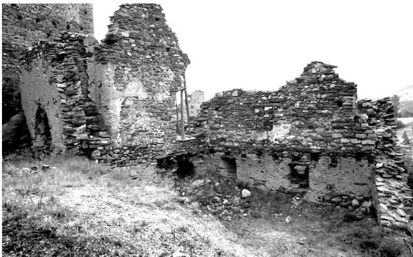
Fig. 10 Castello di Cly, strutture superstiti degli ambienti posti a nord, 1987. In evidenza i primi elementi di messa in sicurezza
