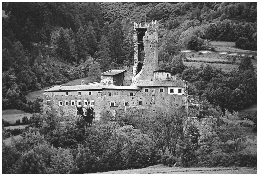
Fig. 10 Castello di Fürstenburg, vista d'insieme da est dopo il crollo della torre, 1994
