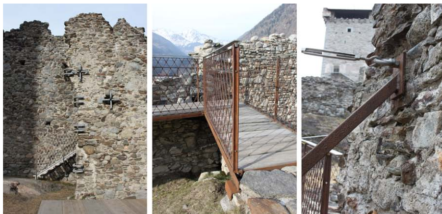
Fig. 121-122-123 Da sinistra: Castello di Ossana, nuove strutture in acciaio inox sabbiato e/o ferro passivato, 2016
