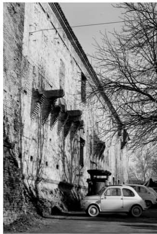
Fig. 25 A sinistra: Castel Sismondo, Ala di Isotta, vista da sud-est, 1962
