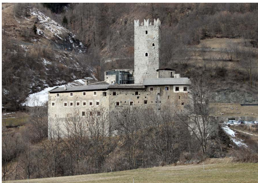
Fig. 11 Castello di Fürstenburg, vista d'insieme da est dopo il restauro, 2016
