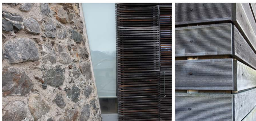
Fig. 124 A sinistra: Castello di Fürstenburg, angolo tra la nuova casa del custode e la muratura storica del cortile intermedio, 2016.
