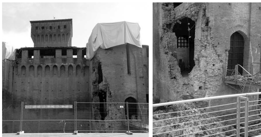
Fig. 3-4 Rocca di San Felice sul Panaro, vista d'insieme e particolare dell'ingresso all'indomani del sisma del 2012, 2013
