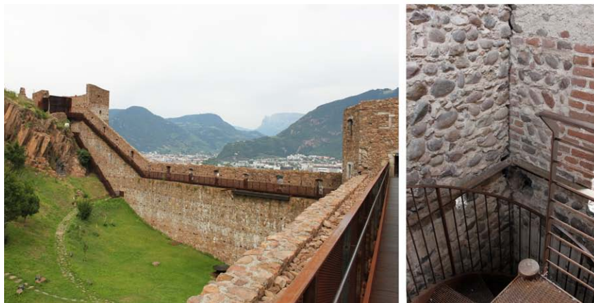
Fig. 126 A sinistra: Castel Firmiano, nuove strutture in acciaio COR-TEN, 2016.
