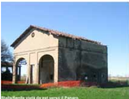
Stalla/rimba vista da est verso il Panaro
