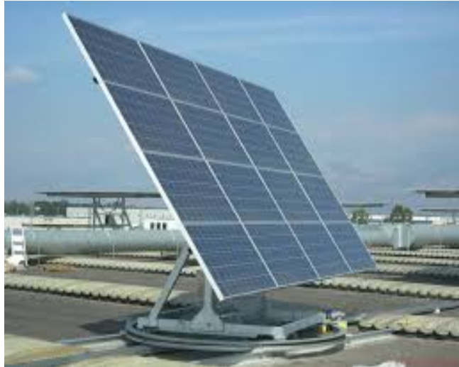
Figura 15: Impianto FV ad inseguimento solare (Fonte: Wikipedia, 2015).
