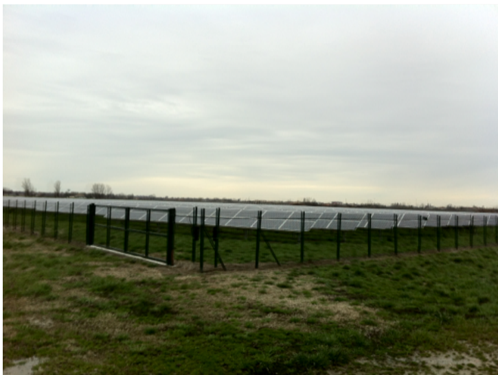
Figura 44: Impianto FV 3. (Fonte: Malagnino et al., 2015).
