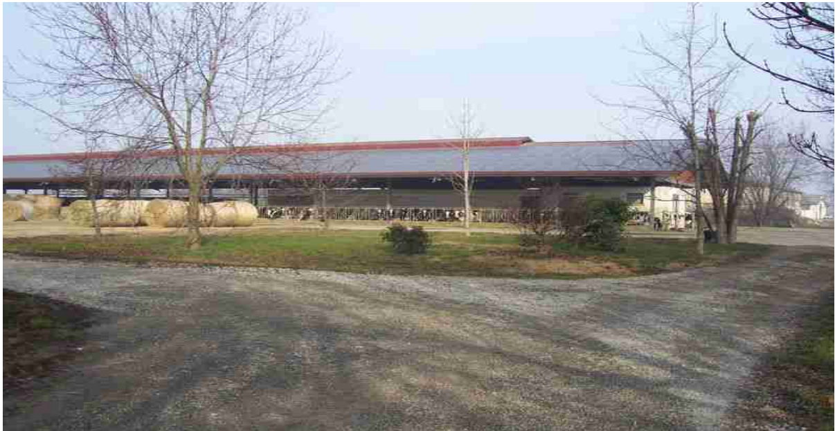
Figura 4: Impianto Fotovoltaico Grid-Connected installato su tetto di stalla per bovini da latte (Source: Malagnino et al., 2015).
