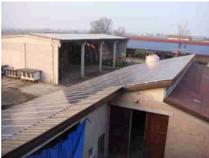
Figura 43: Impianto FV 2. (Fonte: Malagnino et al., 2015).
