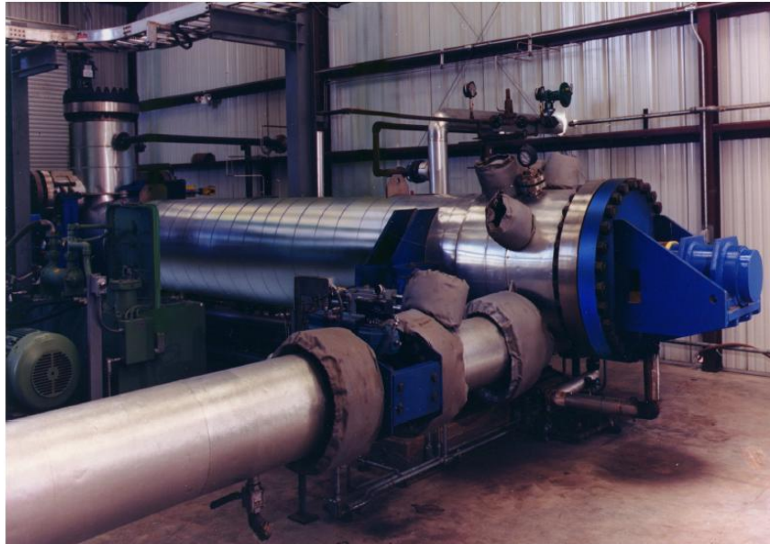
Figura 1.16: Impianto di Steam Explosion
