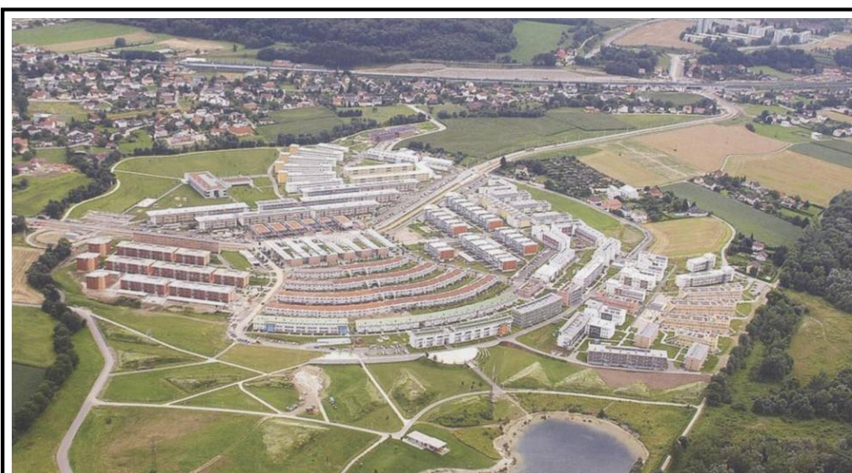
Fig.2.1.8.1 Vista aerea quartiere Solar City ( www.terranauta.it , 4/12/2011)
