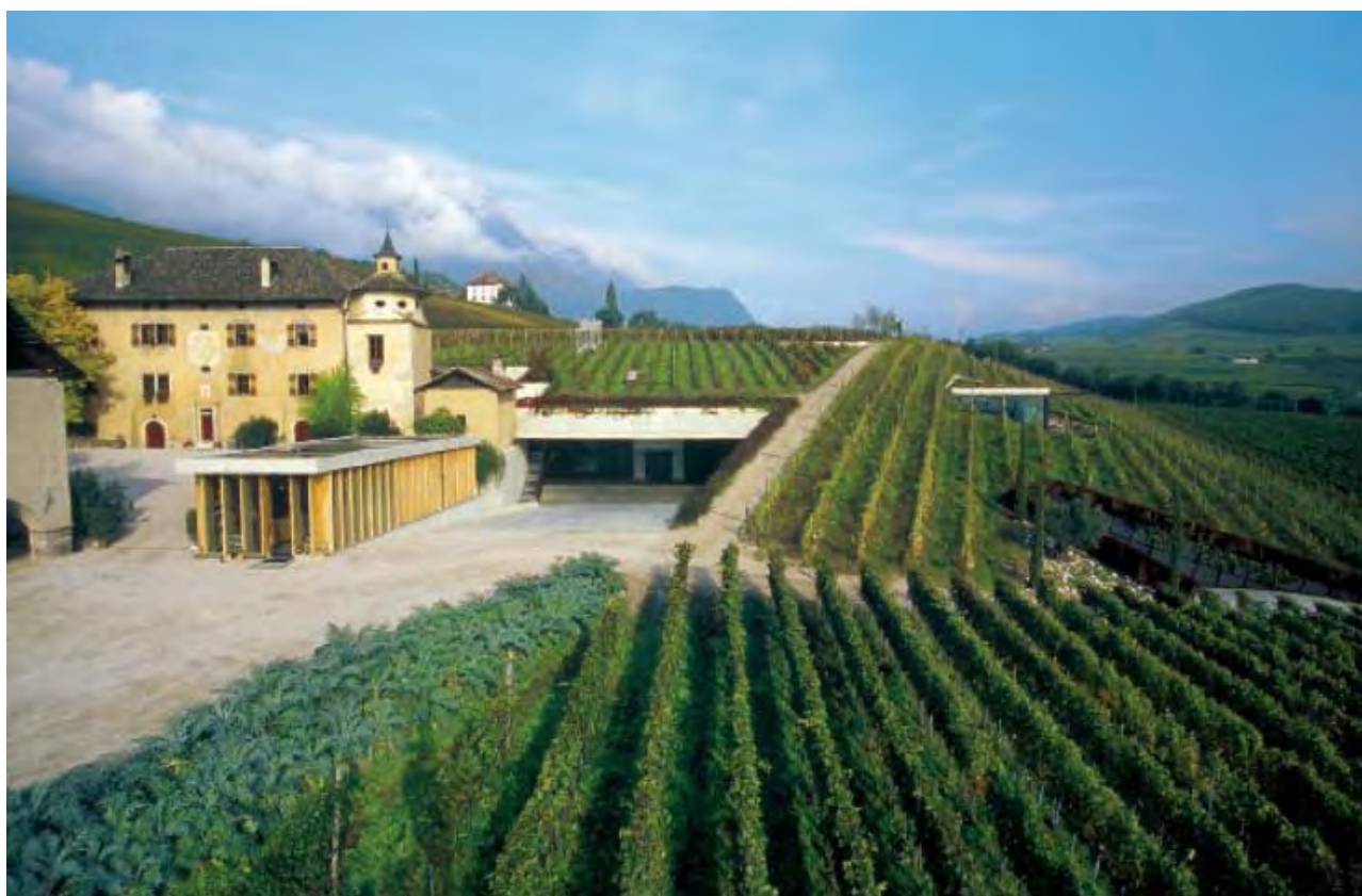
Figura III. 29. Cantina Manincor (Lago di Caldaro, Italia, Arch. Walter Angonese): esempio di cantina ipogea.
