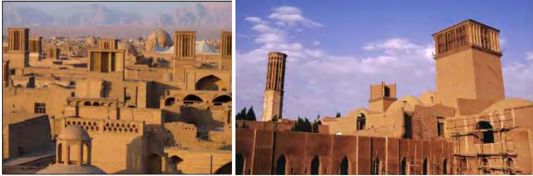
Figura III. 36. Immagini di “torri del vento” in Medio Oriente: nel Bagh – e – Dolat Abad a Yazd in Iran, c’è la torre del vento più alta del mondo, pari a 32 metri da terra, con una velocità del vento pari a 7 m/s.
