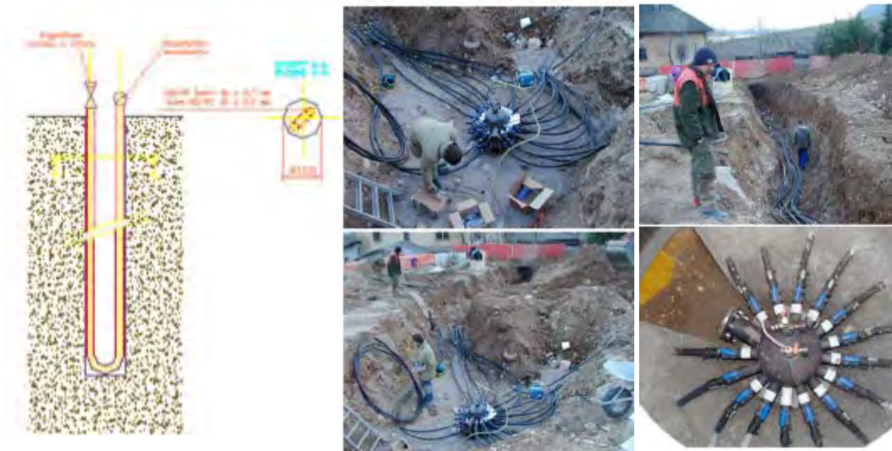
Figura III. 42: Sonda geotermica, collettore e tubazioni di collegamento utilizzate in Cantina Manincor (Caldaro, Italia) 30
