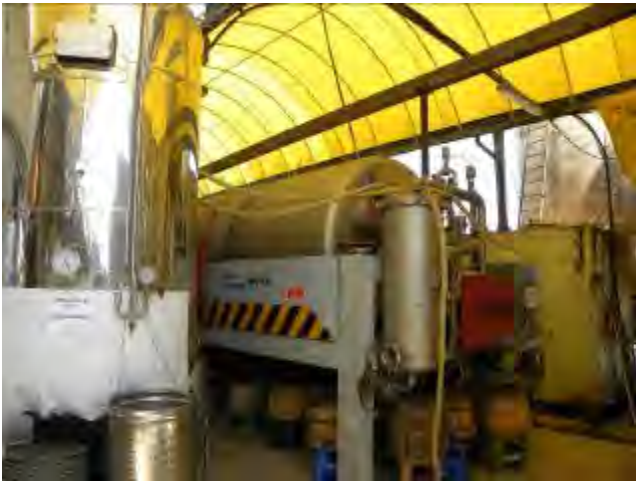
92__Tettoia adiacente alla cantina
