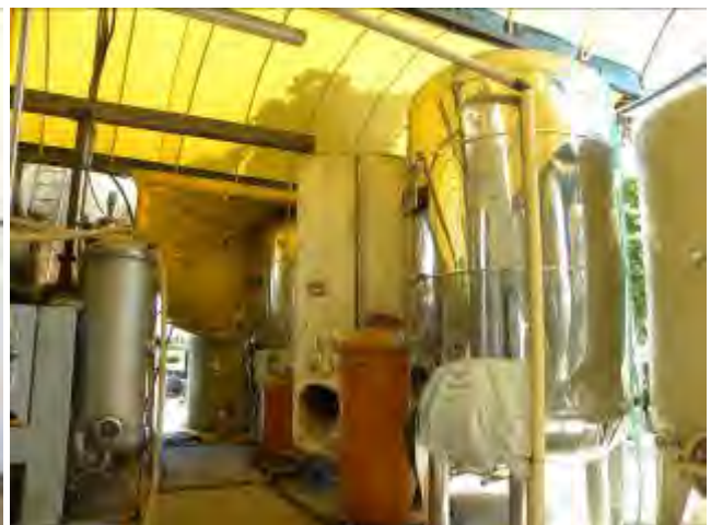
91_Tettoia adiacente alla cantina
