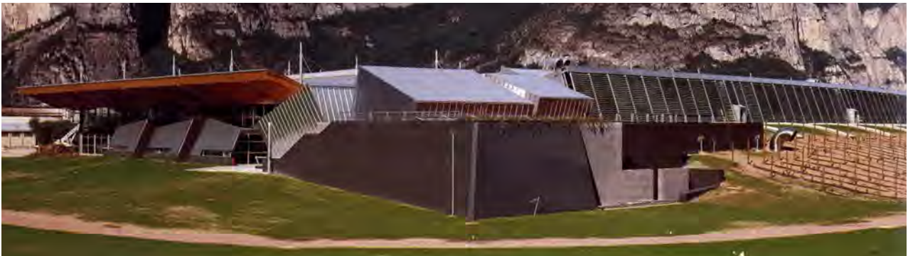
Figura IV.35: Cantine Mezzacorona (Trentino, Italia, 2004), la copertura in legno lamellare è rivestita in zinco-titanio.
