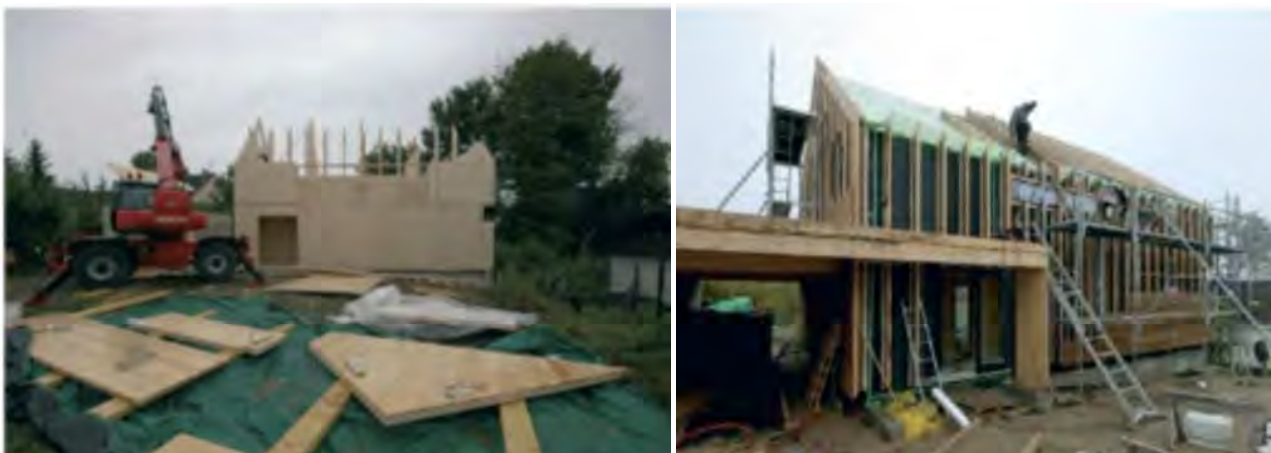
Figura IV.32: immagini di cantiere, realizzazione di edificio con strutture portanti in legno prefabbricate.
