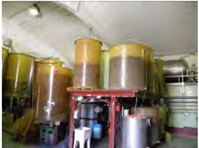
80_Cantina: locale di vinificazione
