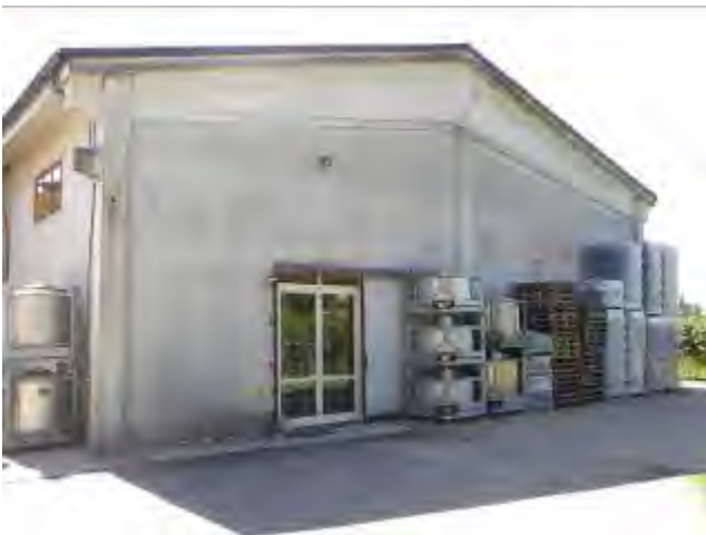
19_Cantina: accesso all'ufficio
