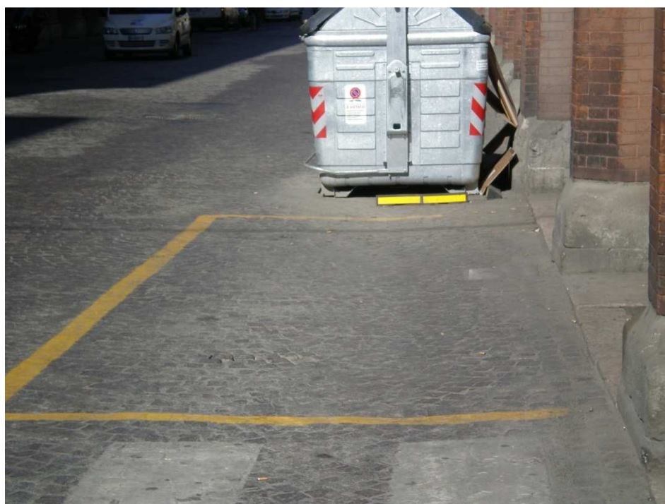
Fig. 5.16: Segnaletica orizzontale in ottimo stato
