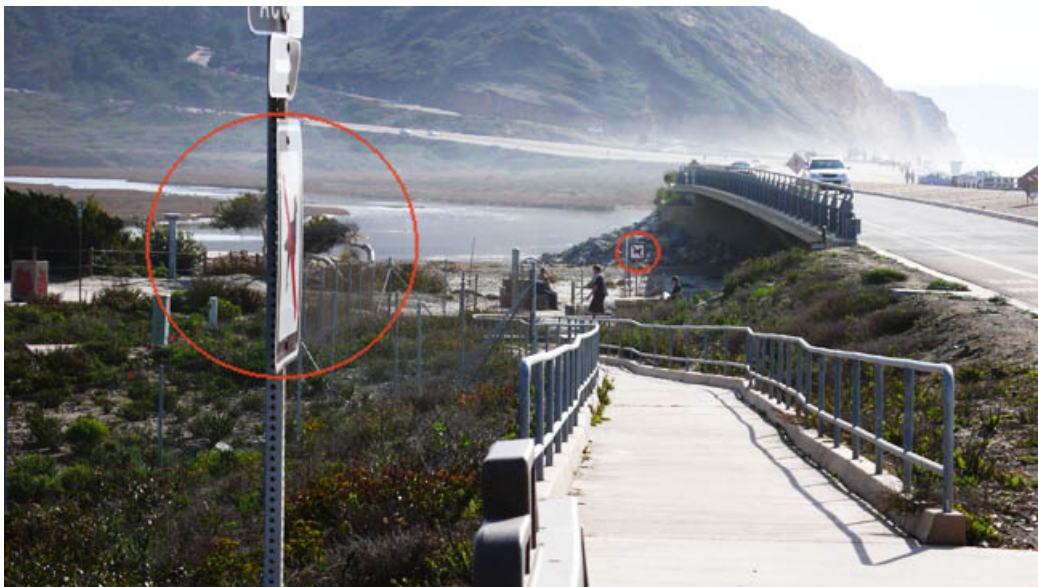
fig. 24b – Accesso ai disabili. Divieti di ingresso ai cani; cerchiati nella foto.
