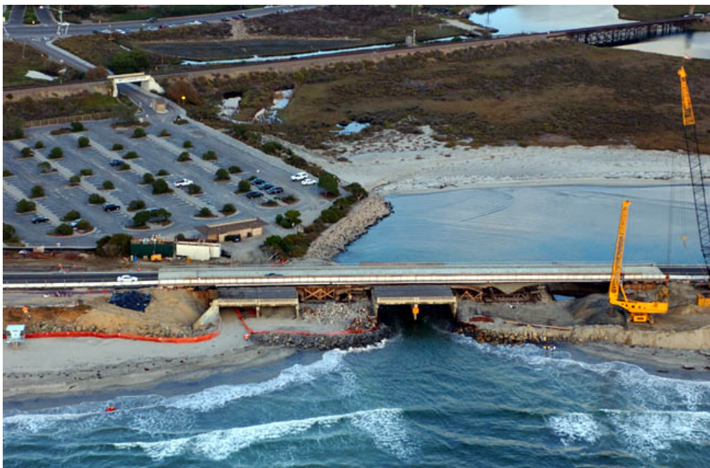
fig. 33 – Lavori di costruzione del nuovo ponte sulla foce della laguna, 23/10/2004 (fonte: California Coastal Records Project 157 )
