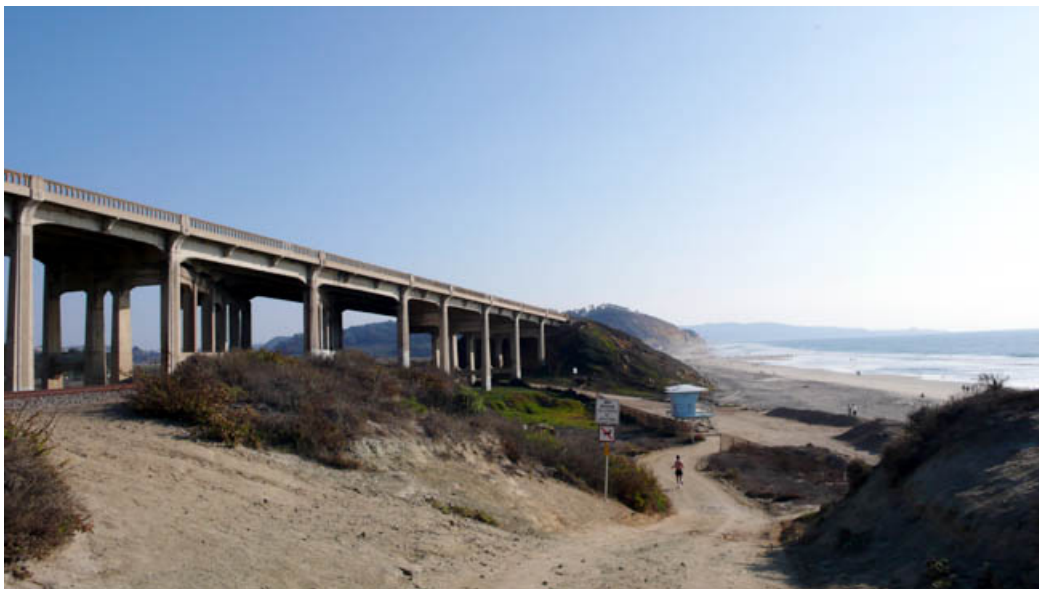
fig. 26 – Il ponte ferroviario “nord” della North Torrey Pines Road (ex McGonigle Road, ora nota anche come la storica 101 Pacific Coastal Highway).
