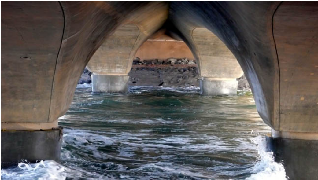
fig. 30a – Passaggio pedonale sotto al ponte: vista centrale, direzione sud.
