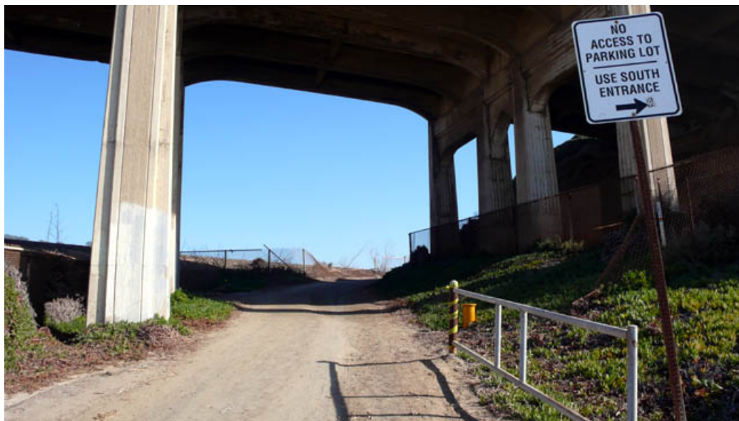
fig. 36 – Accesso nord al parcheggio nei pressi della foce: entrata di “servizio” alla spiaggia, per scopi di manutenzione o sorveglianza
