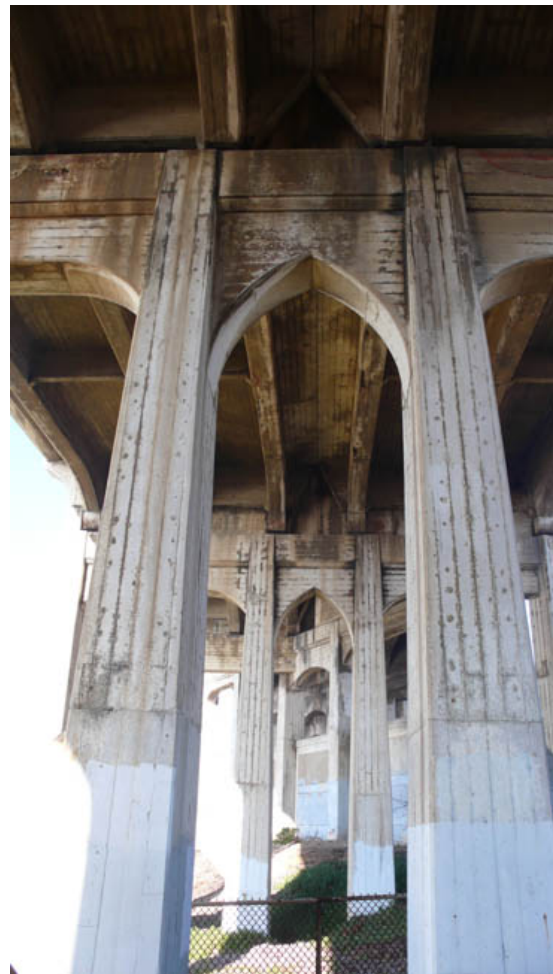
fig. 27 b – Particolare architettonico ad “arco gotico” del ponte a nord, sulla ferrovia.
