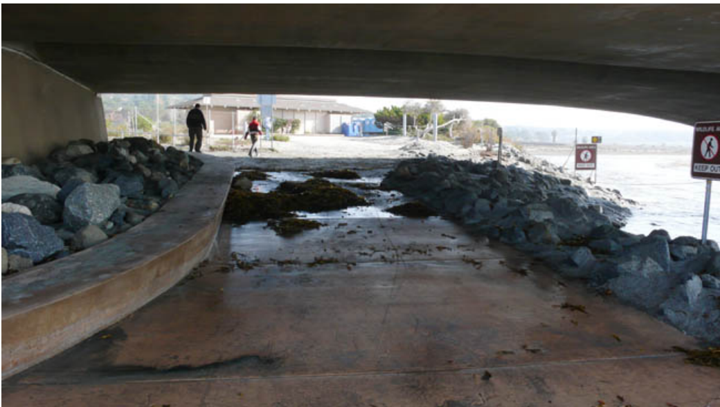
fig. 30b – Passaggio pedonale sotto al ponte: muretto laterale, direzione parcheggio (est).
