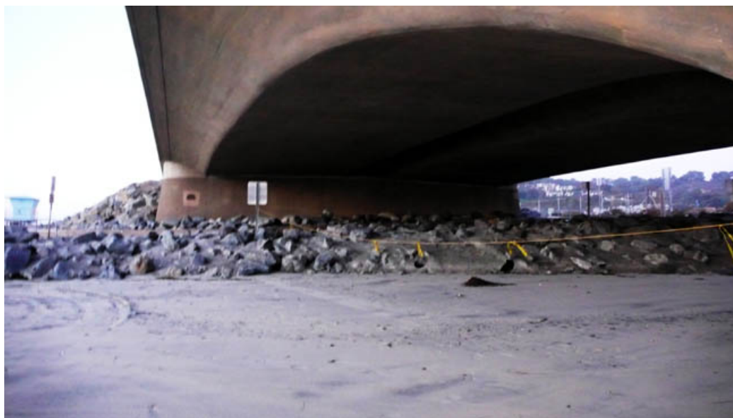
fig. 22c – Wildlife Area Limit , parte laterale settentrionale e parte periferica sotto al ponte: delimitazione della fune gialla.
