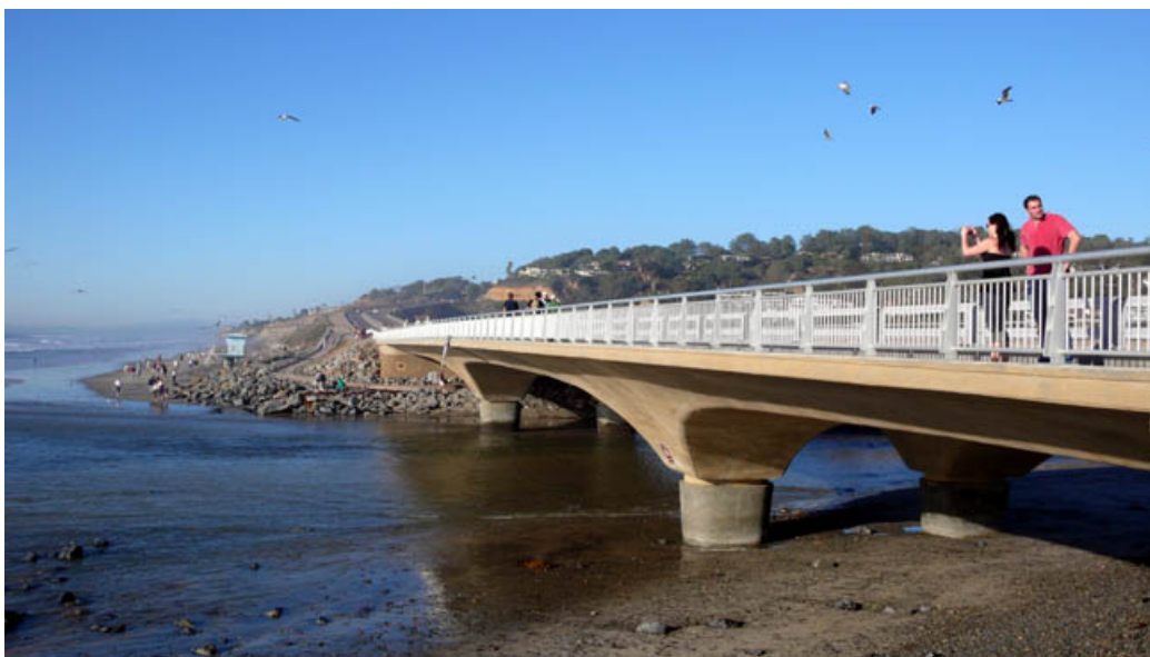
fig. 29a - passaggio pedonale sopra il ponte, in direzione nord.
