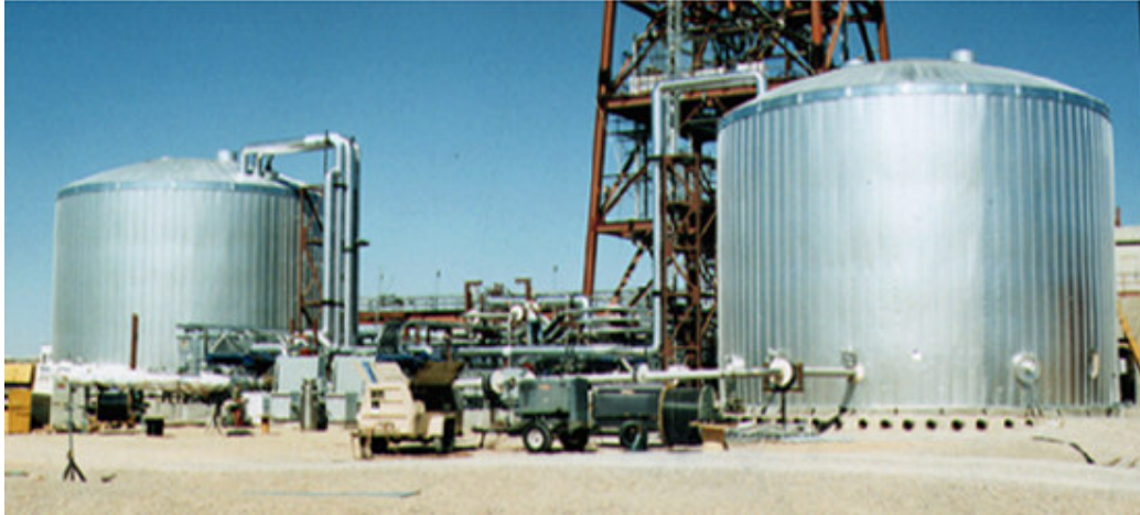
Figura 6 – Serbatoi ad accumulo dell'impianto Solar Two
