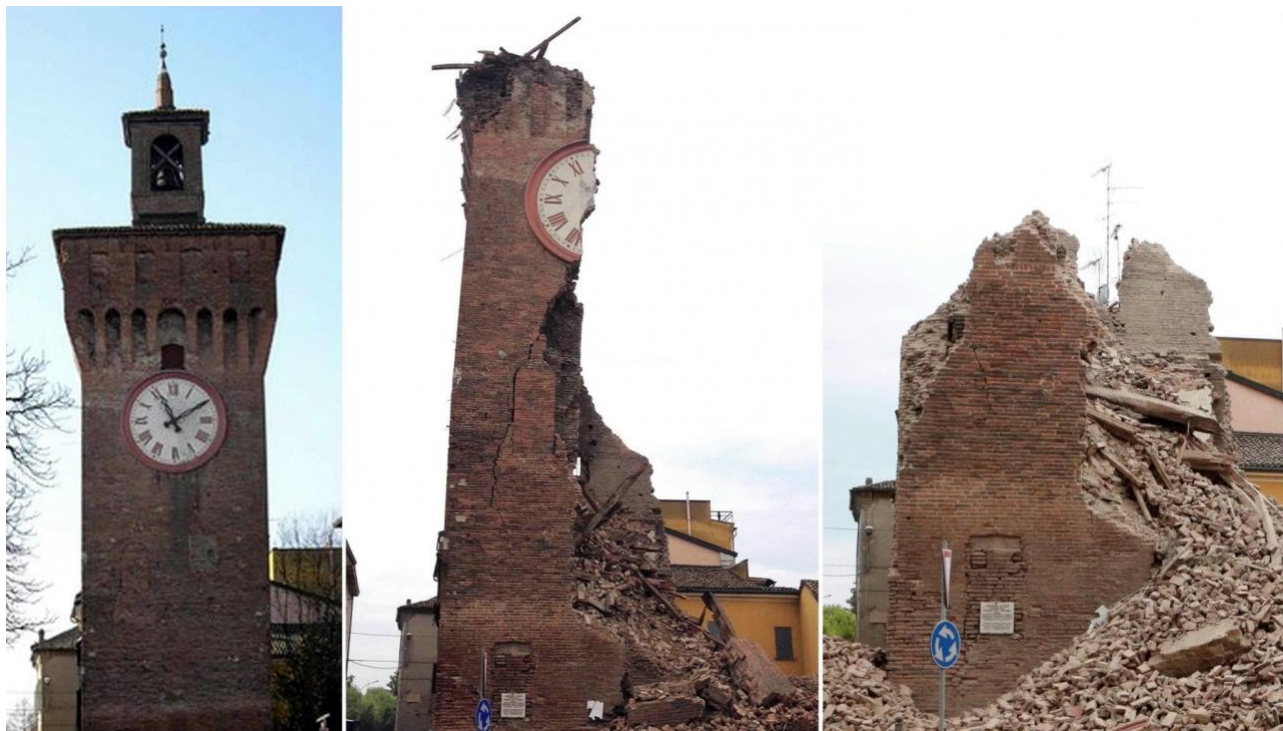
Figura 18: la Torre dei Modenesi di Finale Emilia (MO), diventata il simbolo del terremoto del 2012, com'era prima del terremoto, dopo la prima scossa del 20 maggio e dopo la seconda scossa del 29 maggio. 145
